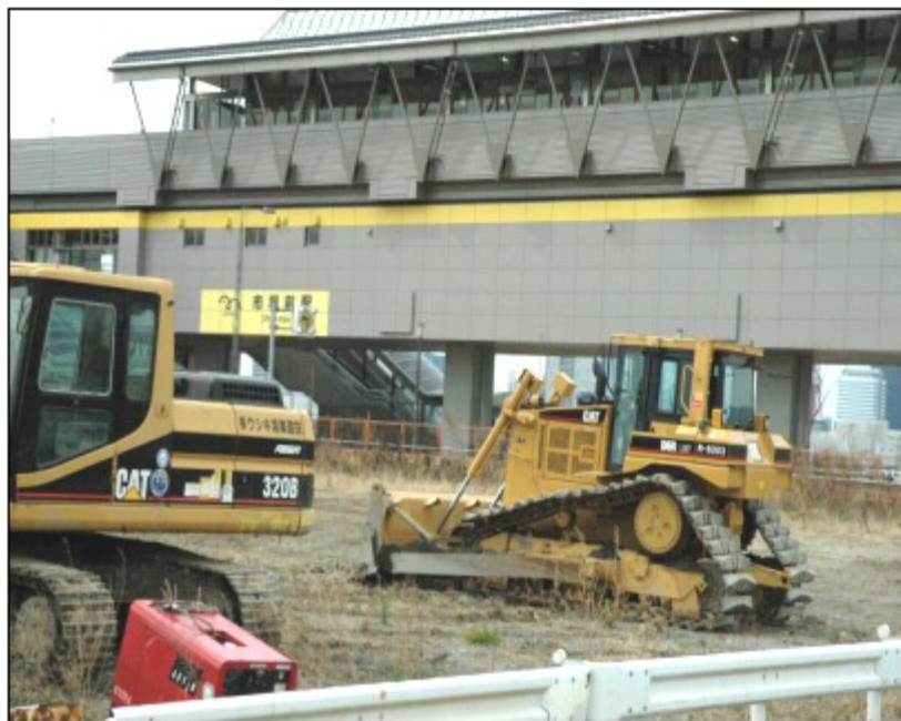
汚染された東京ガス跡地の掘削作業
